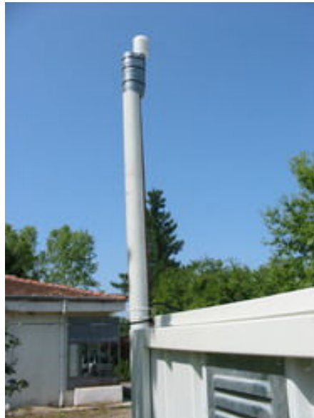
Zaman sinyali almak için GPS anteni monte edilmiştir.
