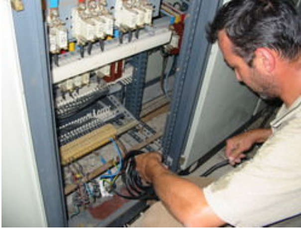
Elektirik hattı yandaki binadan deprem istasyonuna çekilmiştir.
