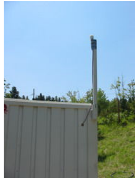
Zaman sinyali almak için GPS anteni monte edilmiştir.
