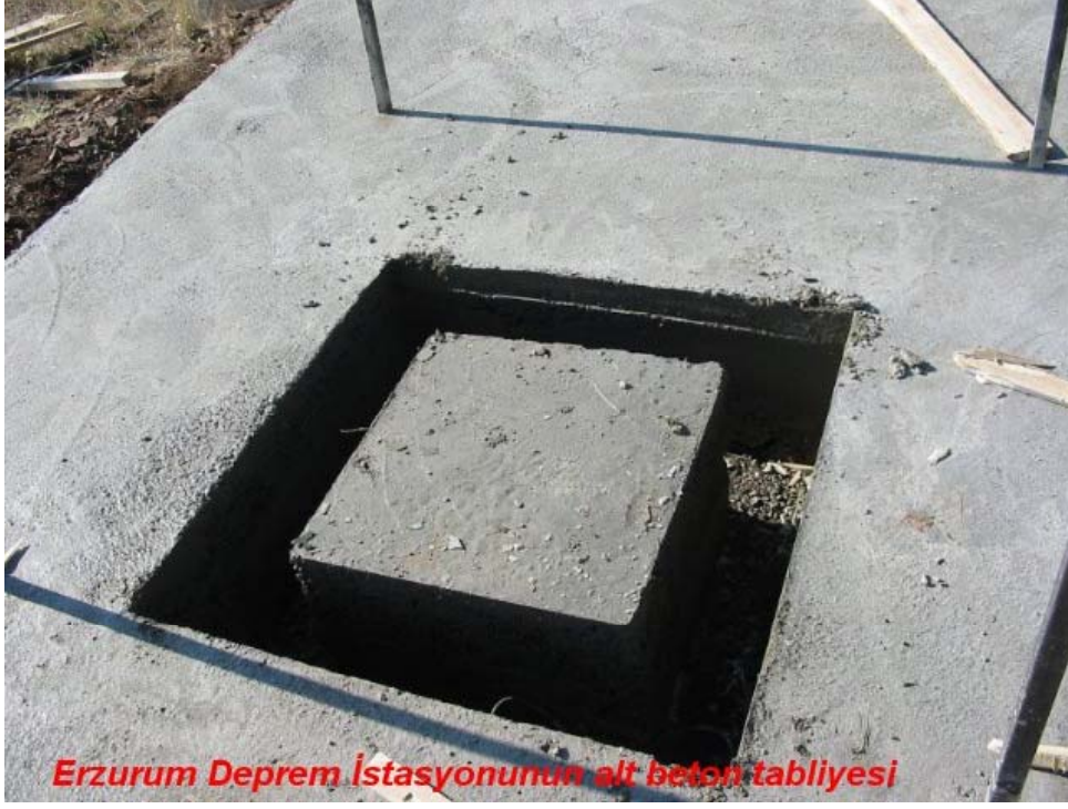
Deprem istasyonunun dökülmüş beton tabliyesi
