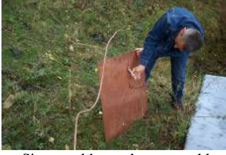
Sistem yıldırıma karşı topraklama yapılarak koruma altına alınmıştır.
