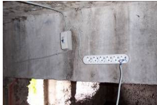
Elektrik tesisatı çalışması.
