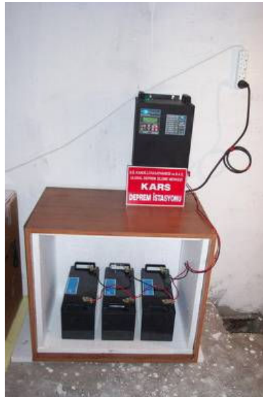
Aküler ile sistemin çalışmasında gerekli olan ekipmanlar bina içerisine monte edilerek bağlantıları yapılmıştır.
