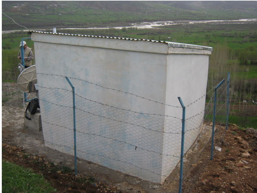
Deprem istasyonu olarak kullanılan bina.
