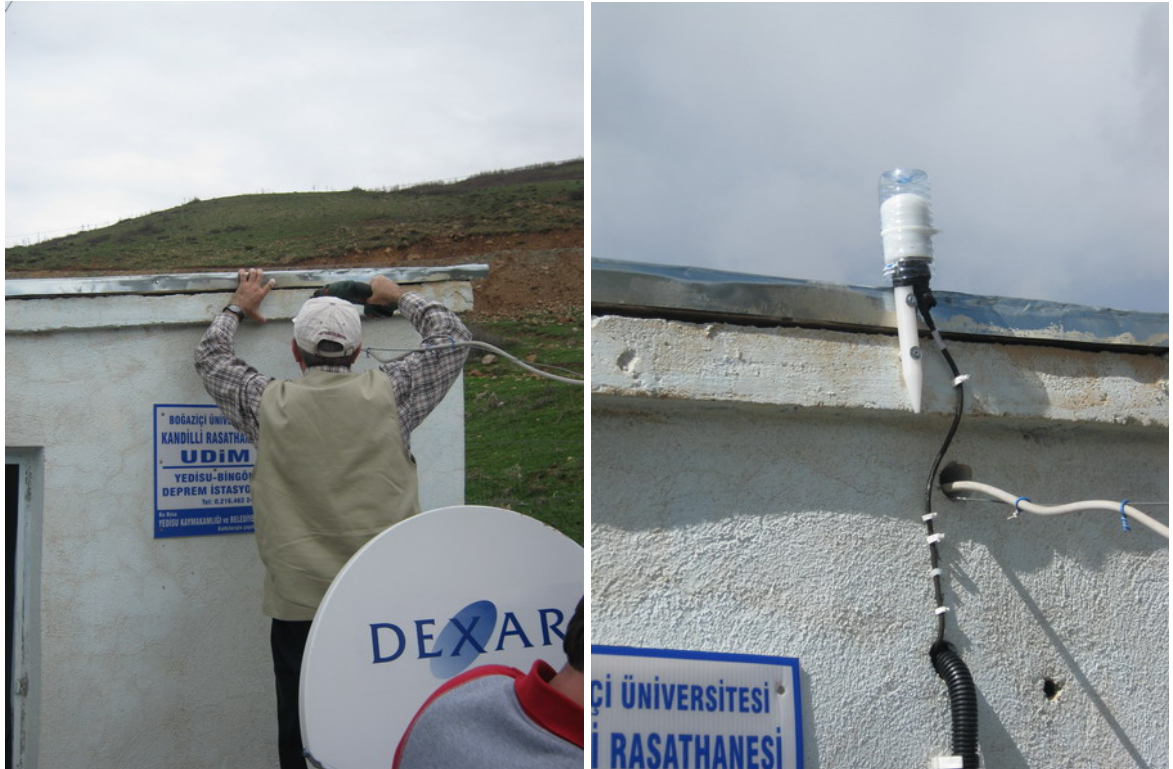
Zaman sinyali almak için GPS anteni çatıya monte edilmiştir.
