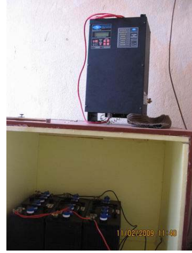
Akü grubu ve şarj ünitesi montajı
