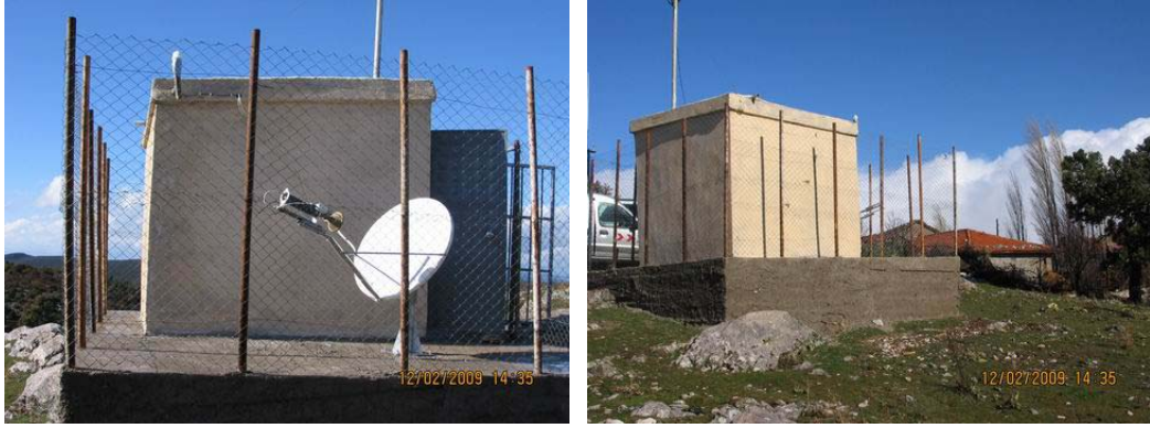
Tavşanlı Deprem İstasyonu Genel Görünüş
