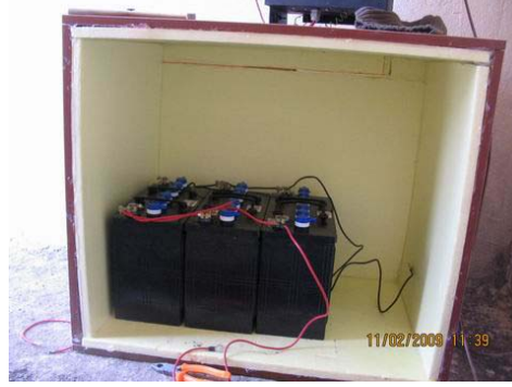
Akü grubu ve şarj ünitesi montajı
