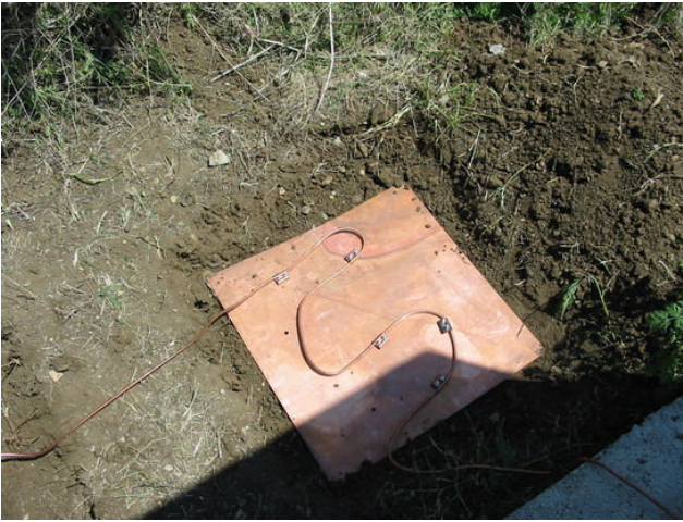
Sistem yıldırıma karşı topraklama yapılarak koruma altına alınmıştır.
