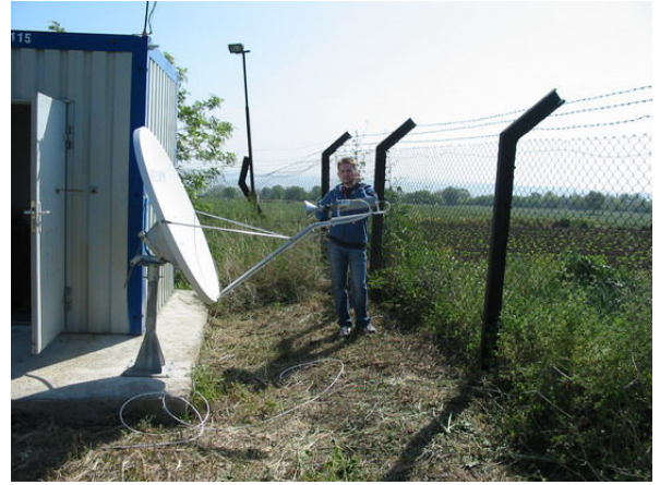
İletiřimi saęlamak amacı ile Uydu Anteni montajı yapılmıřtır.
