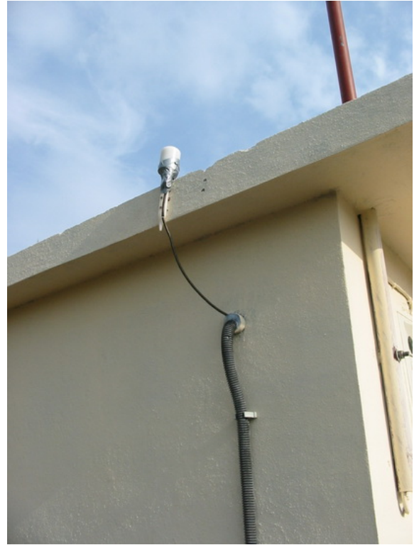
Zaman sinyali almak için GPS anteni çatıya monte edilmiştir.
