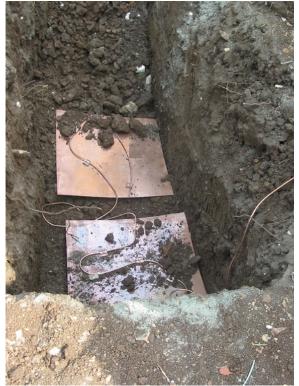
Sistem yıldırıma karşı topraklama yapılarak koruma altına alınmıştır.
