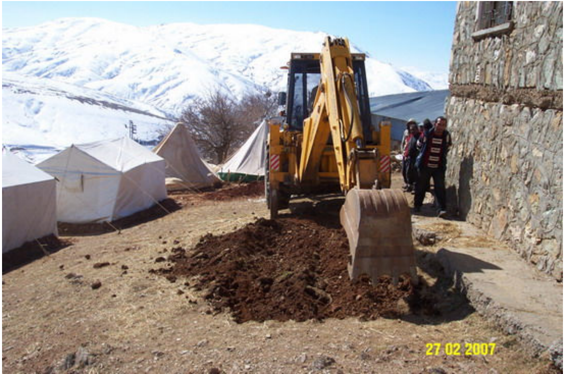
Alt Yapı –Kazı Çalışmaları
