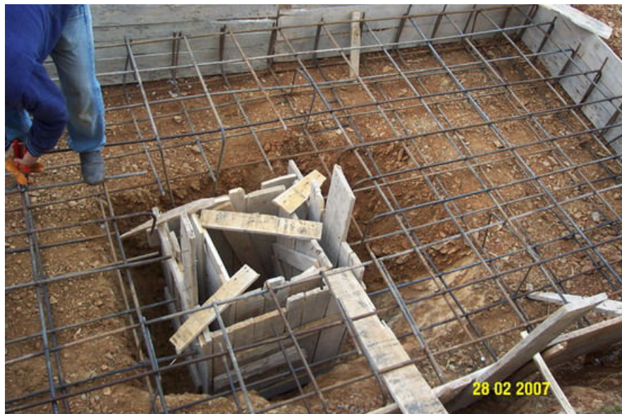
Demir bağlama ve temel betonu için hazırlık çalışmaları
