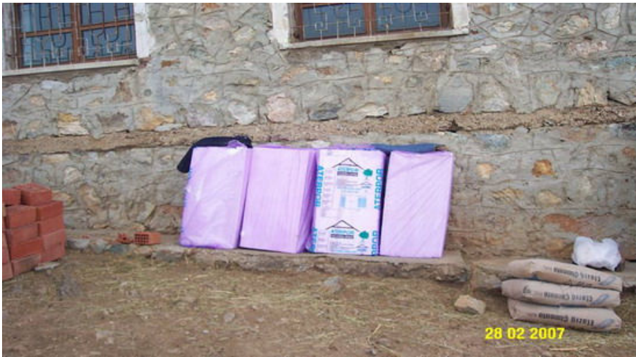
Malzeme temini ve ulařtırılması alıřmaları
