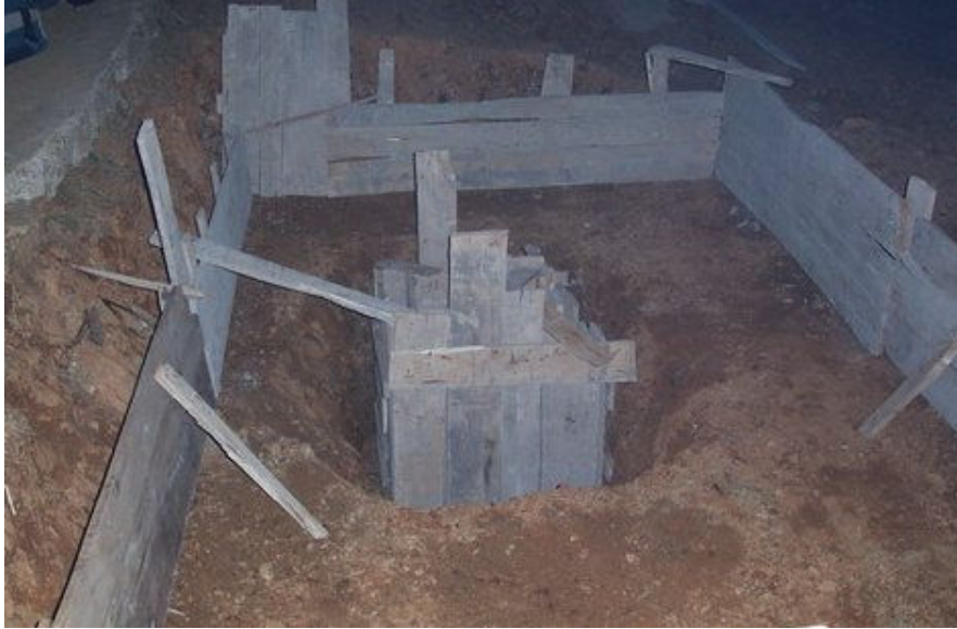
Sismometre Pilye Kuyusu ve Alt Tabliye çalışmaları
