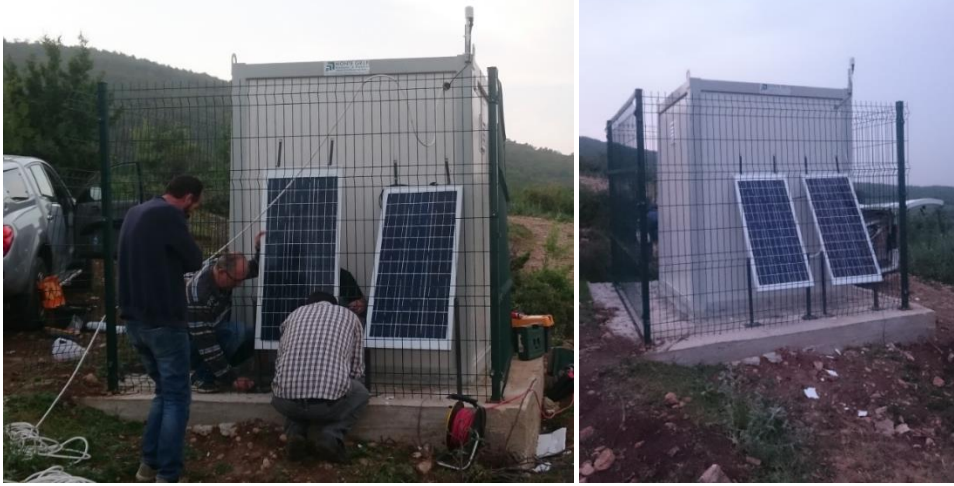
Güneş Paneli ve GPS anten montajı yapıldı
