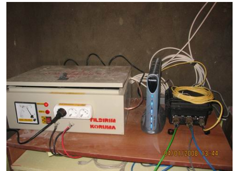
Akü grubu ve şarj ünitesi ile DCM ve DIRECWAY'ın montajı
