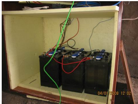
Akü grubu ve şarj ünitesi ile DCM ve DIRECWAY'ın montajı
