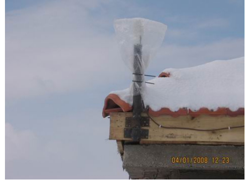
Uydu Anteni ile GPS anteni montajı yapımı.
