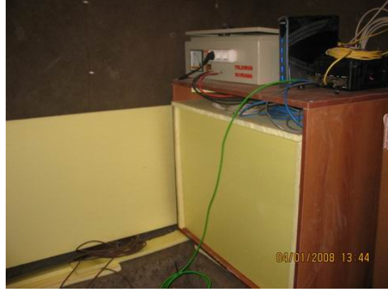
Akü grubunun ısı izolasyonunun sağlanması ve şarj ünitesinin çalıştırılması
