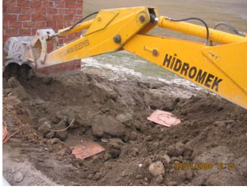
Topraklama için kazı yapılması ve topraklama levhalarının gömülmesi
