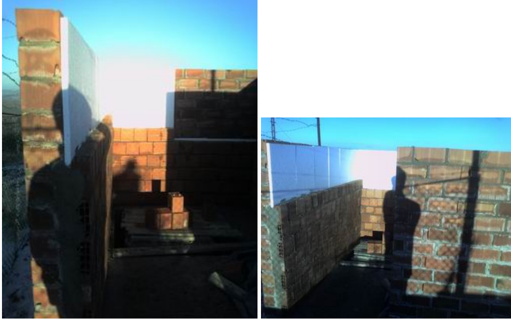
Duvarların ısı yalıtımlı olarak yapımı
