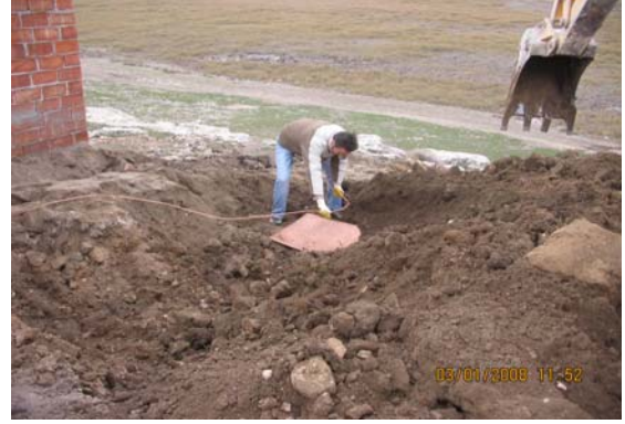
Topraklama için kazı yapılması ve topraklama levhalarının gömülmesi
