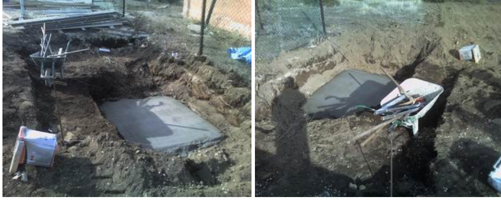
Alt Yapı Çalışmaları
