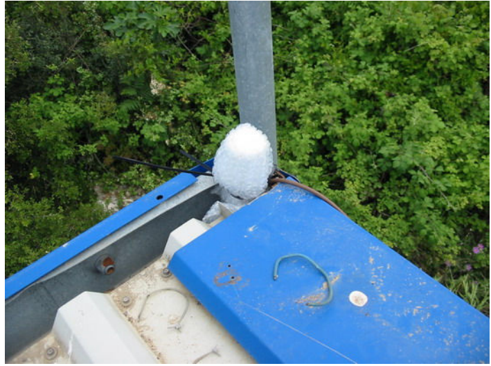
Zaman sinyali almak için GPS anteni çatıya monte edilmiřtir.
