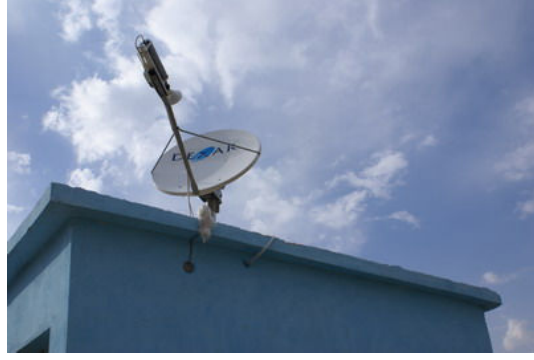
İletiřimi saęlamak amacı ile Uydu Anteni montajı yapılmıřtır.
