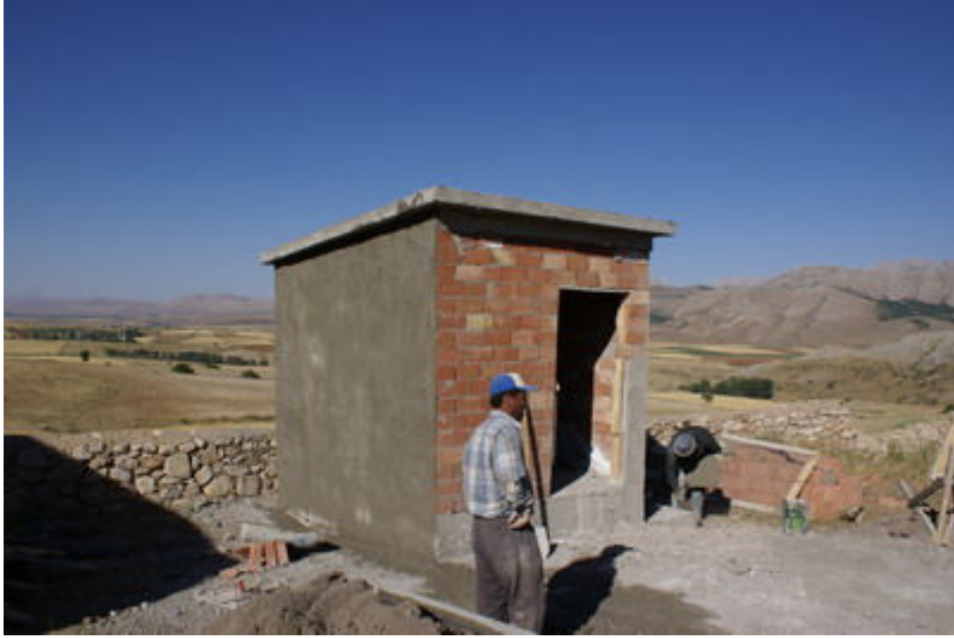
Alt Yapı çalışması
