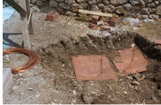
Sistem yıldırıma karřı topraklama yapılarak koruma altına alınmıřtır.
