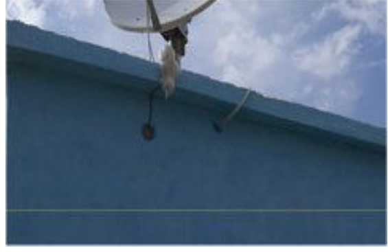
Zaman sinyali almak için GPS anteni çatıya monte edilmiştir.
