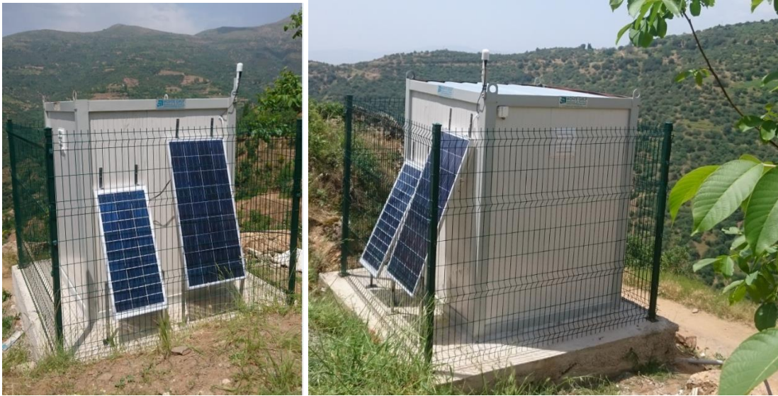
Güneş Paneli ve GPS anten montajı yapıldı
