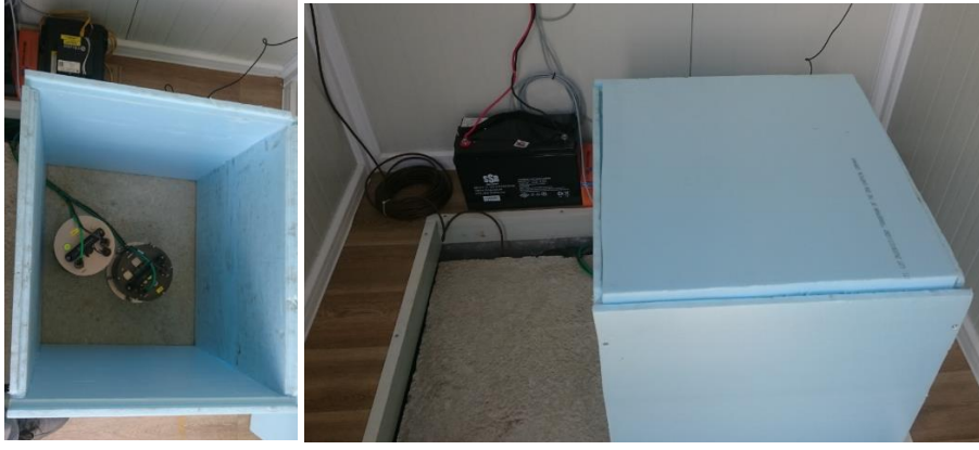
Sismometrelerin ısı yalıtımları yapıldı
