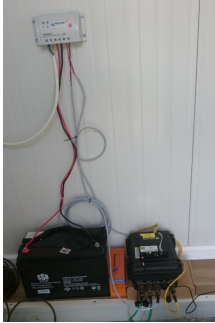
EAM, GPRS Modem, Akü ve Güneş Regülatörü montajı yapıldı.
