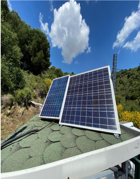
İstasyonun kapı kilidi değiştirildi. Ek olarak 75 watt güneş paneli eklendi. Güneş paneli regülatörü değiştirilerek oksitlenen bağlantı kabloları yenilendi. Gps anten değiştirildi.
