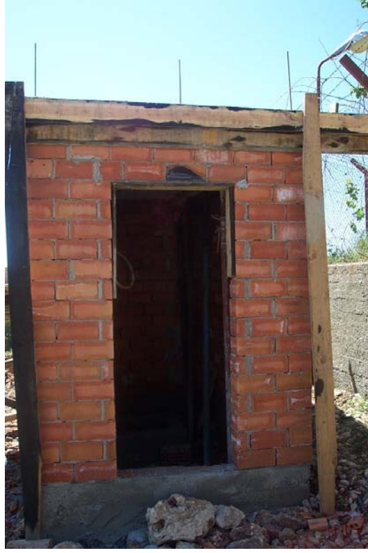
Binanın Dış duvarlarının örölmesi ve tavan betonunun atılması
