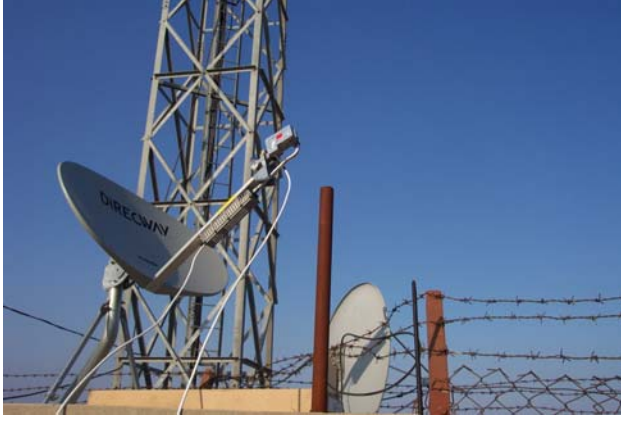
Koruma Ünitesi ve sinyali uyduya gönderen çanak, Uydu Modem-Aküler ve GPS bağlantılarından bir görünüm
