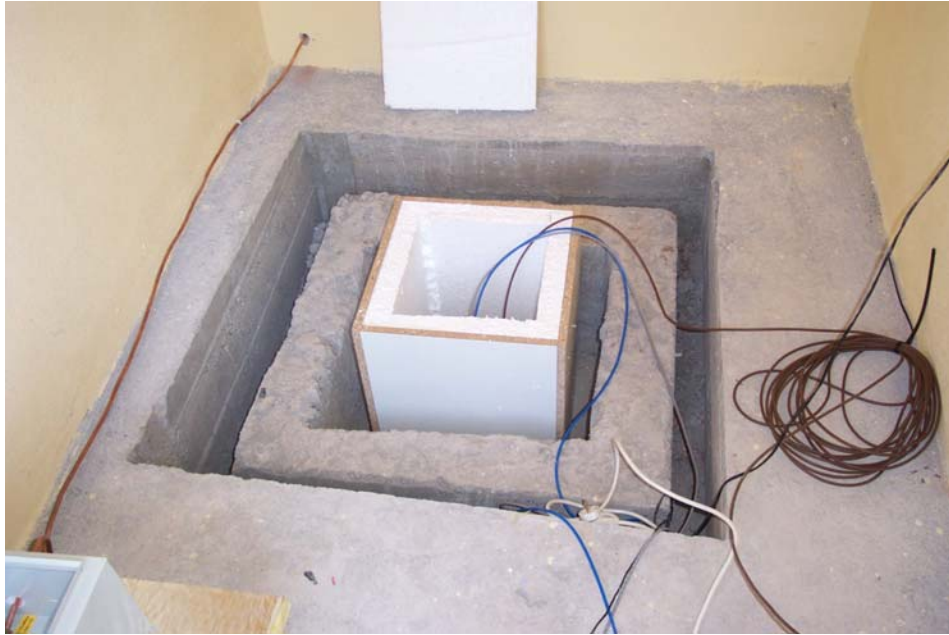
Sismometrenin koyulacağı kuyunun yapılması
