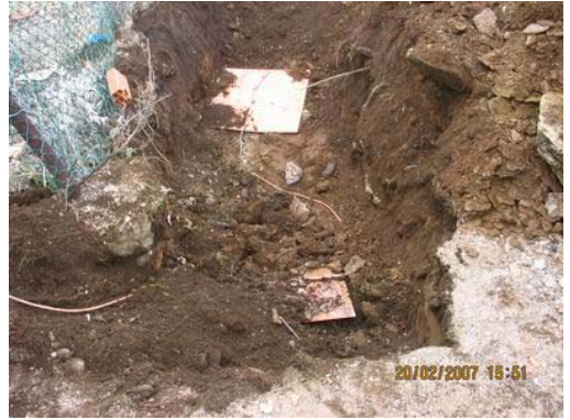
Topraklama için kazı yapılması ve topraklama levhalarının gömülmesi
