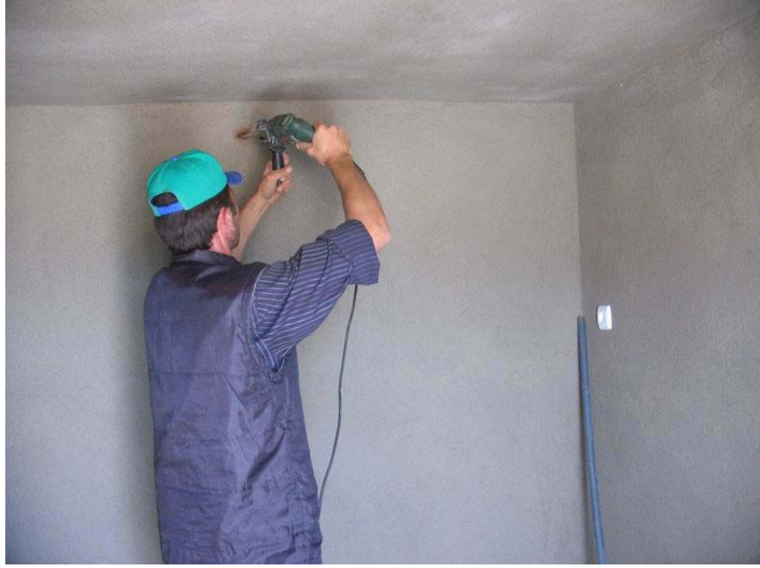
Binaya elektrik tesisatı çekilme alıřmaları
