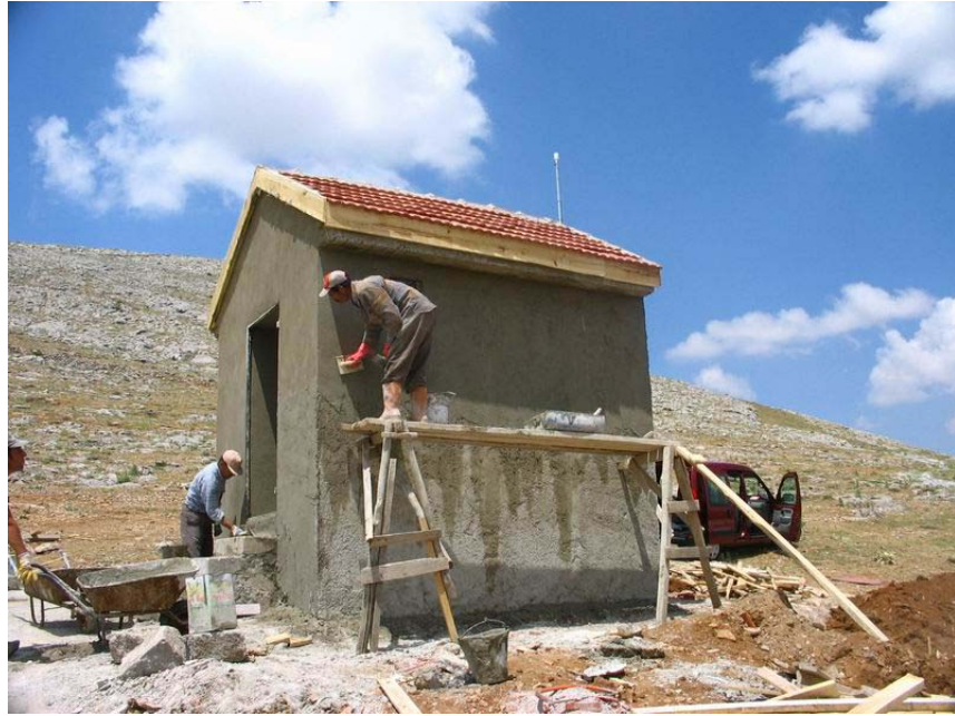
Kaba inşaatın bitirilmesi,iç ve dış sıva yapımı
