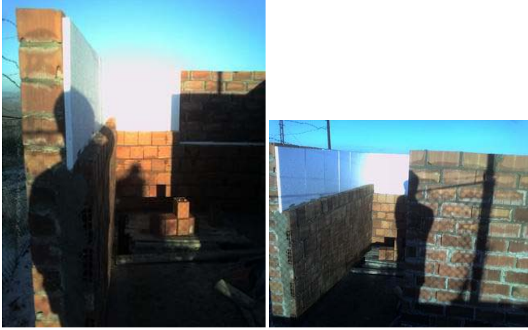
Deprem İstasyonu yapımı (duvarlar ısı yalıtımlı olarak yapılmıştır)
