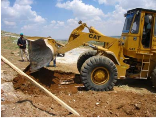
Topraklama için kazı yapılması ve topraklama levhalarının gömülmesi
