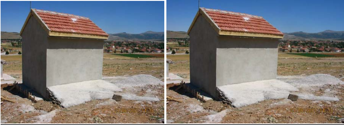
Ladik Deprem İstasyonu'nun bitmiş haldeki görüntüsü
