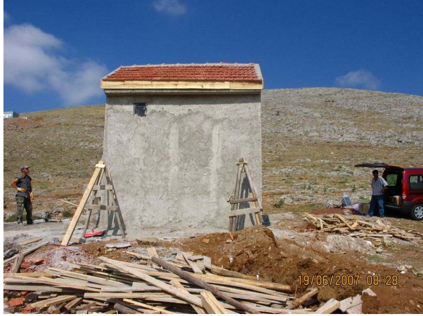
Deprem İstasyonu yapımı
