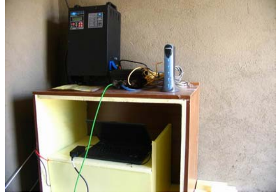
Akü grubu ve şarj ünitesi ile DCM ve DIRECWAY'ın montajı
