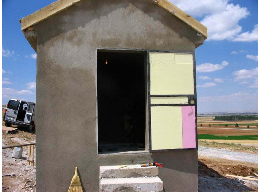
Deprem İzasyonu Binasının Kapısının Isı Yalıtımı yapımı
