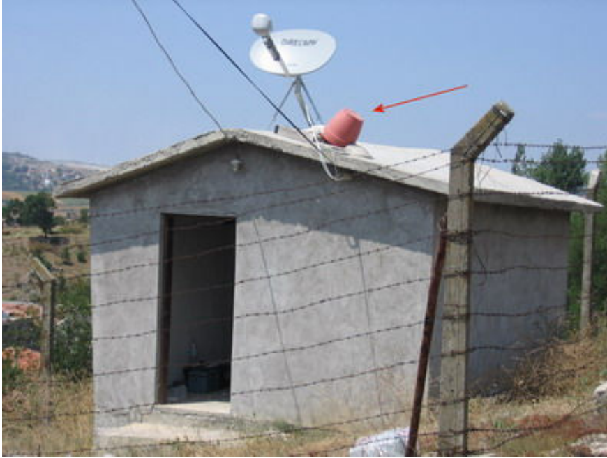
Zaman sinyali almak için GPS anteni çatıya monte edilmiştir.
