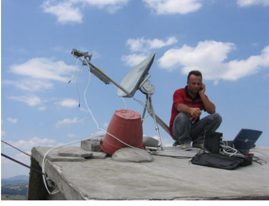
İletişimi sağlamak amacı ile Uydu Anteni montajı yapılmıştır.
