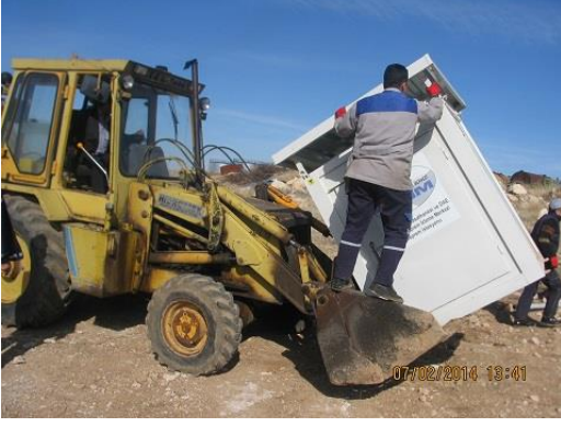
Konteyner sismometre pilyesi üzerine montaj edildi.
