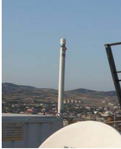
Zaman sinyali almak için GPS anteni çatıya monte edilmiştir.
