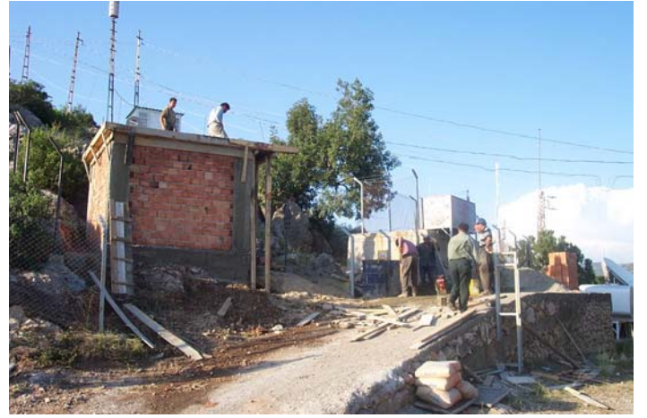
Binanın dış duvarlarının örülmesi ve tavan betonunun dökülmesi
