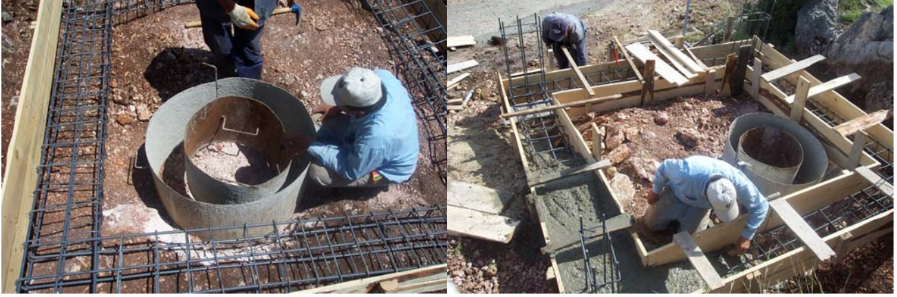
Sensör Kuyusunun Hazırlanması
