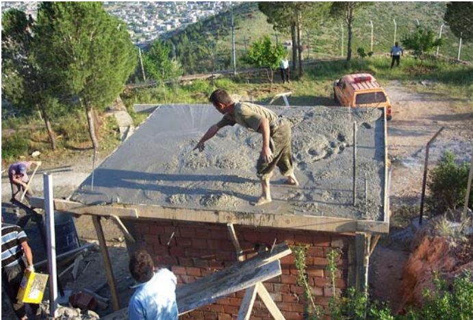
Binanın dış duvarlarının örülmesi ve tavan betonunun dökülmesi
