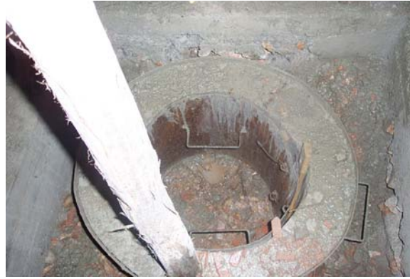
Sensör Kuyusunun Hazırlanması
