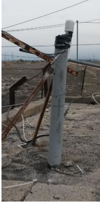
GPS anteni montajı yapıldı
