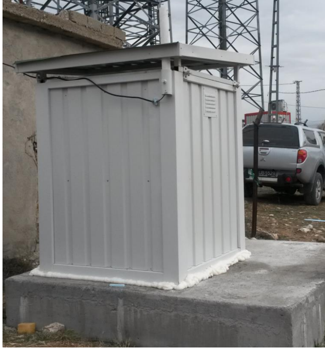
3 x 3 m'2 lik beton zemin hazırlandı, konteyner montajı yapıldı
