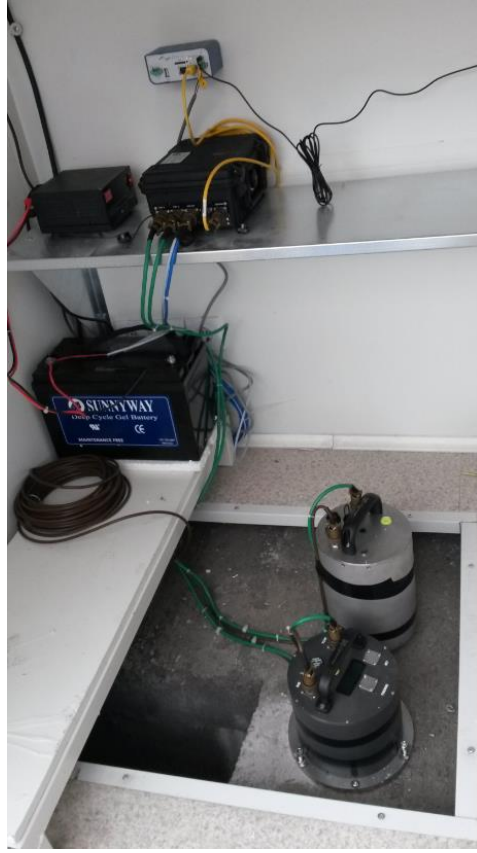
Modem, EAM Modülü, Akü ve Sismometre montajı yapıldı
