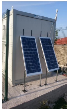
Güneş Paneli ve GPS anten montajı yapıldı
