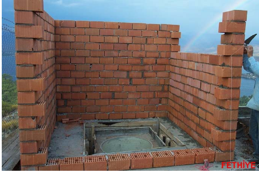
İstasyonun dış cephe duvarlarının örülmesi
