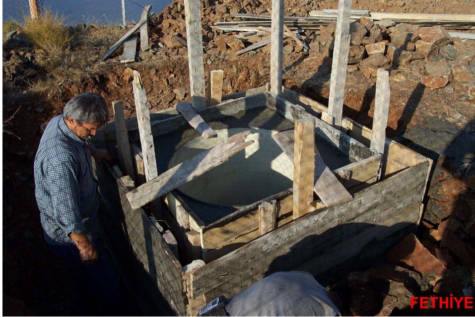
Sismometrenin koyulacağı kuyunun yapılması ve kalıp dökülmesi
