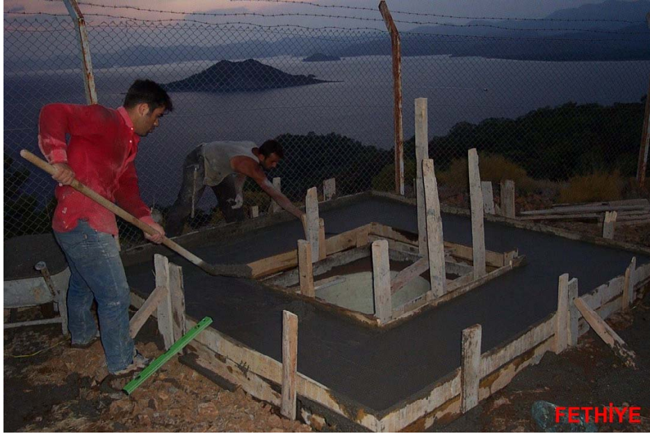
Beton dökülmesi
