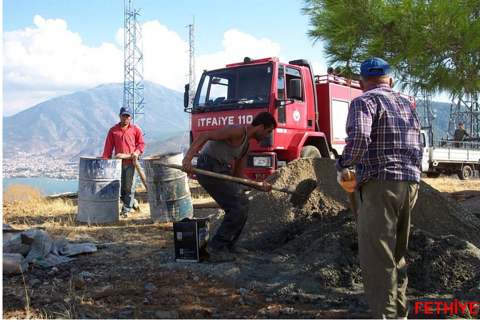
Harç yapımı ve su, malzeme temini
