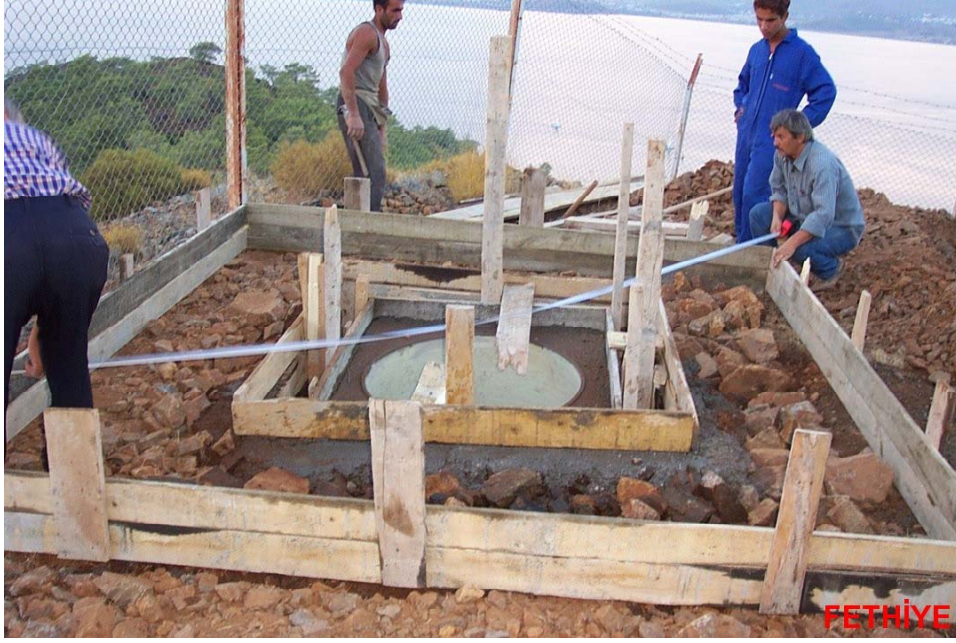
Binanın alt tabliyesinin yapılması
