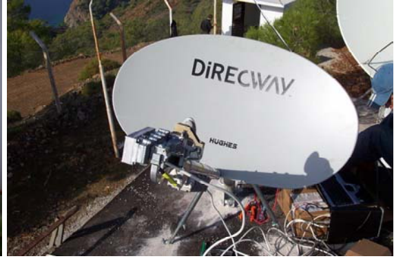
Koruma Ünitesi ve sinyali uyduya gönderen çanaktan bir görünüm
