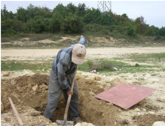
Sistem yıldırıma karřı topraklama yapılarak koruma altına alınmıřtır.
