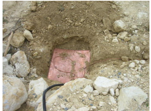
Sistem yıldırıma karřı topraklama yapılarak koruma altına alınmıřtır.
