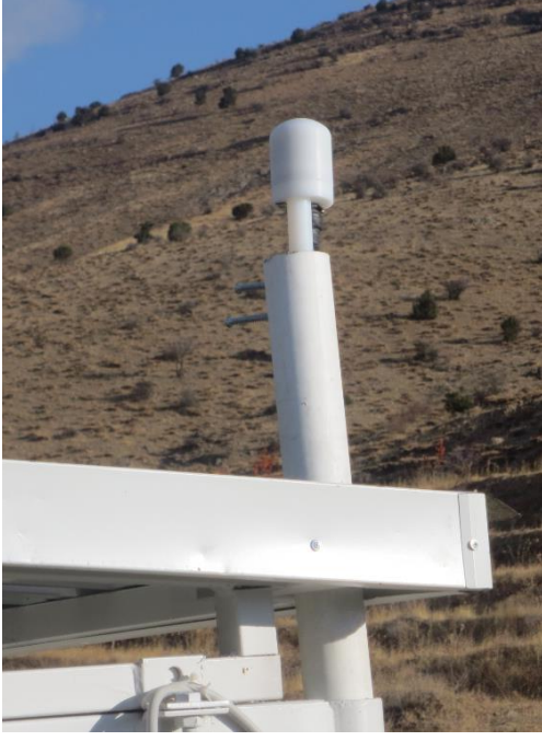
GPS ve GPRS anten montajı yapıldı
