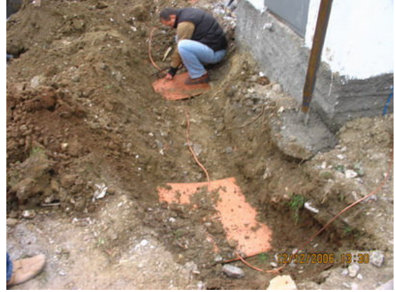
Sistem yıldırıma karşı topraklama yapılarak koruma altına alınmıştır.
