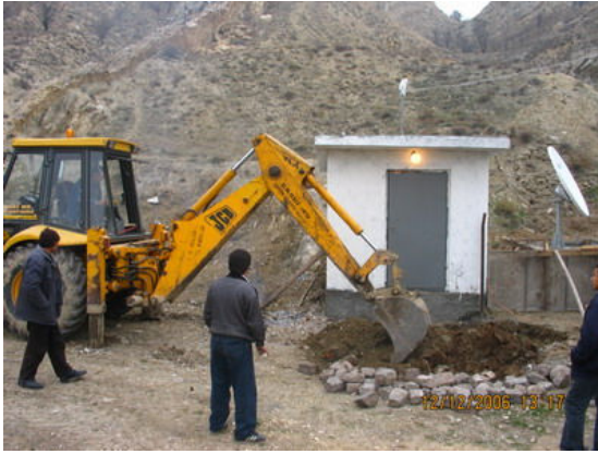
Sistem yıldırıma karşı topraklama yapılarak koruma altına alınmıştır.
