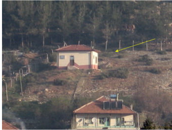
Deprem istasyonu olarak kullanılan bina..
