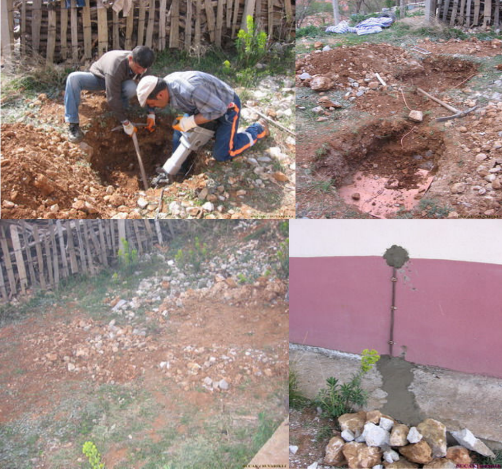
Sistem yıldırıma karşı topraklama yapılarak koruma altına alınmıştır.
