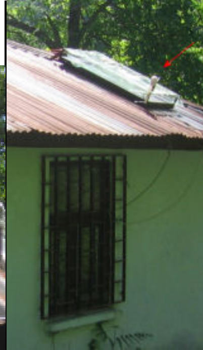
Zaman sinyali almak için GPS anteni çatıya monte edilmiştir.
