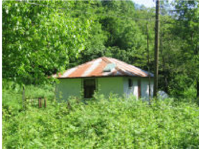
Deprem istasyonu olarak kullanılan bina..
