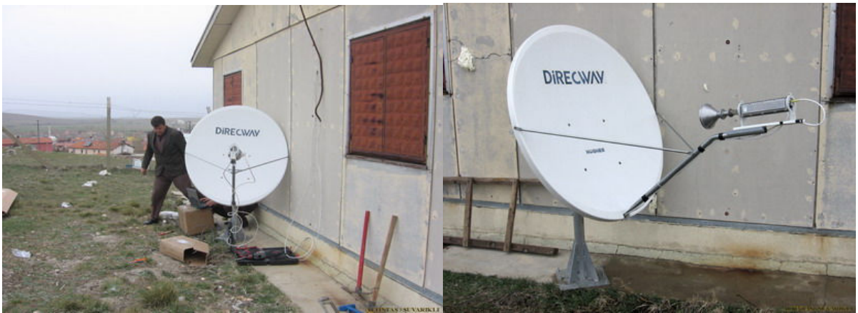
İletiřimi saęlamak amacı ile Uydu Anteni montajı yapılmıřtır.
