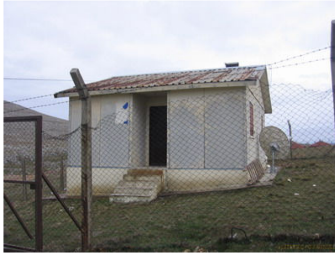
Deprem istasyonu olarak kullanılan bina..
