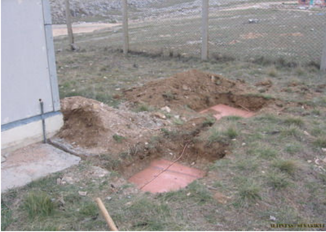
Sistem yıldırıma karşı topraklama yapılarak koruma altına alınmıştır.
